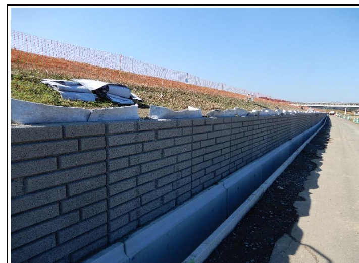
ブロック設置
