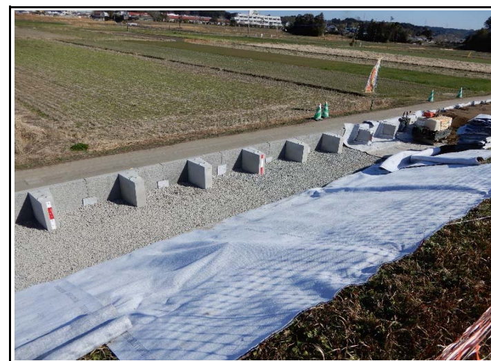
ドレーン材投入
