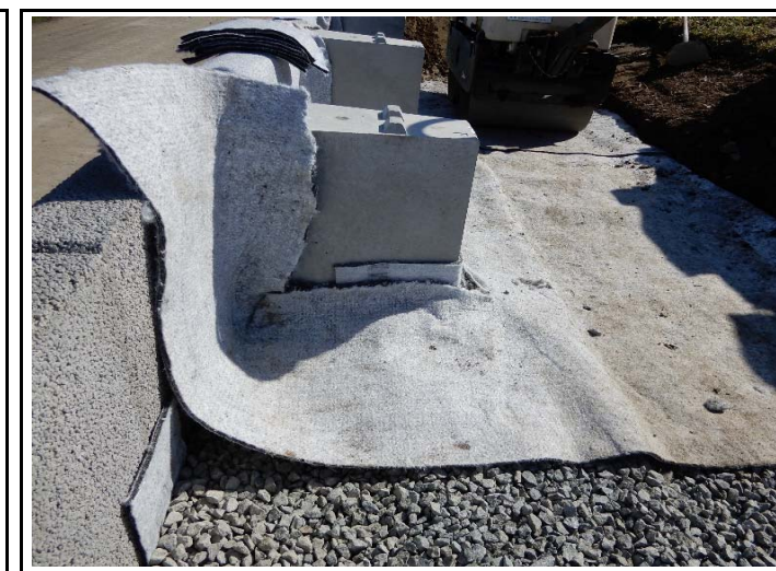
吸出防止材設置
