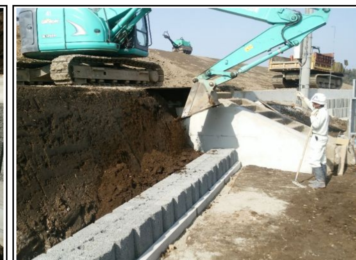
裏込材投入状況
