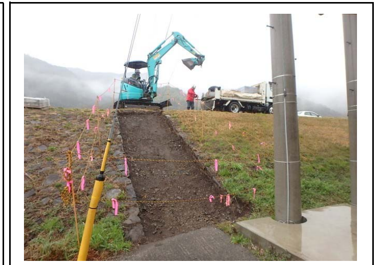
既設階段撤去
