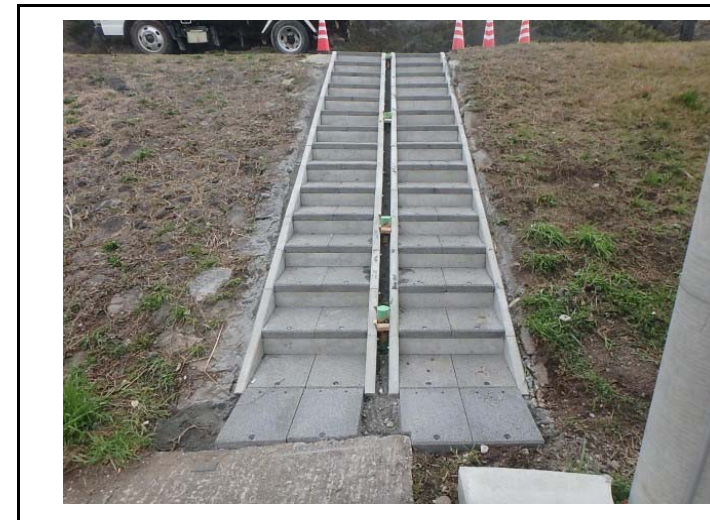
階段設置完了
