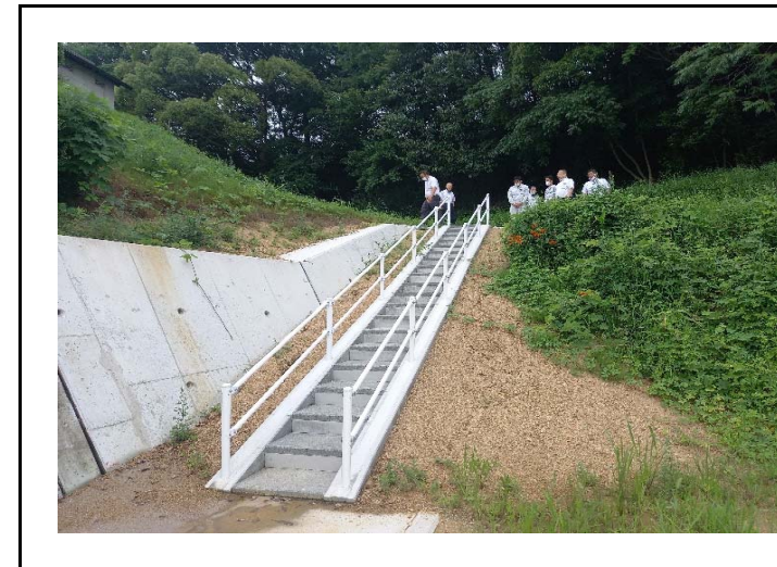
階段設置完了
