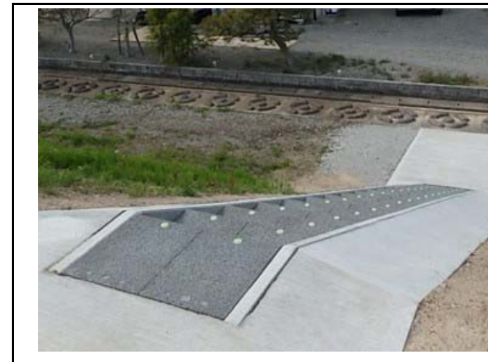
階段設置完了
