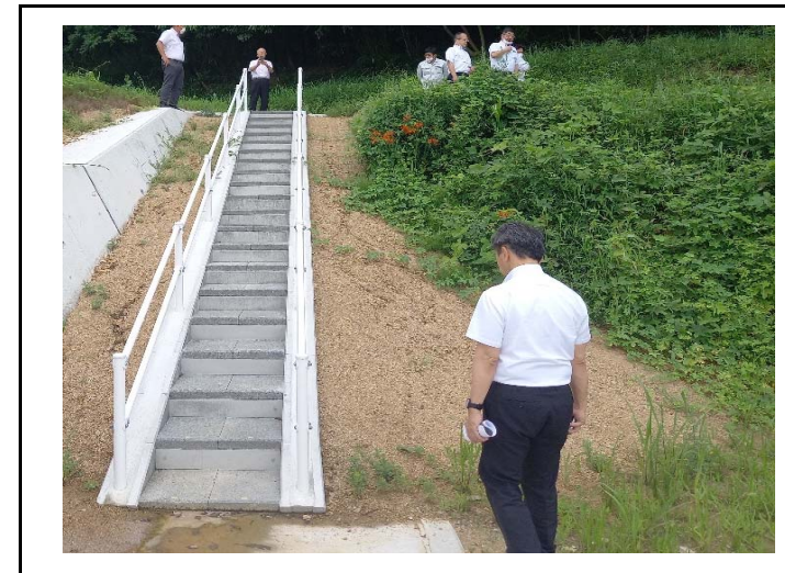
階段設置完了
