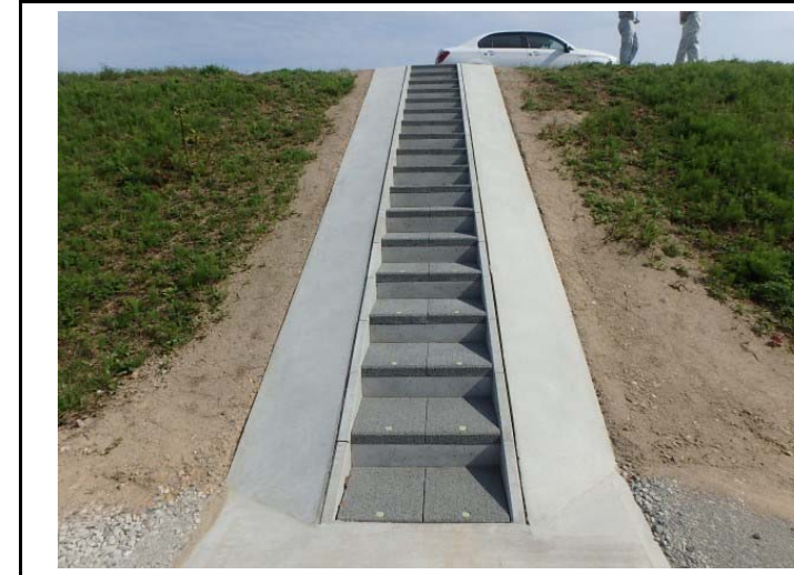
階段設置完了
