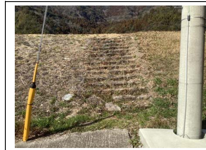
既設石積み階段
