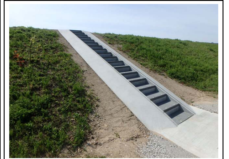
階段設置完了
