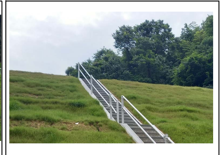
階段設置完了
