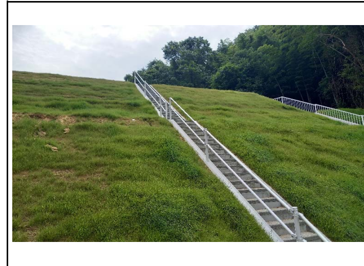
階段設置完了
