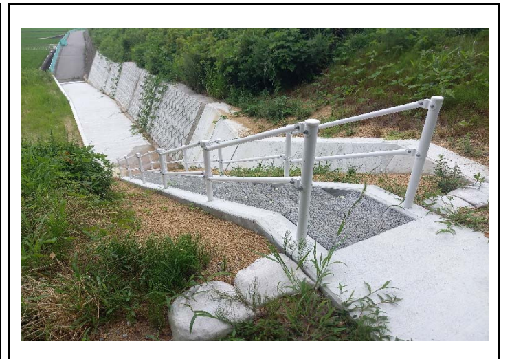
階段設置完了
